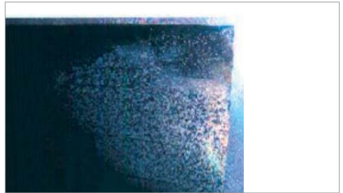
Bild 25: Verfärbung Absorberbeschichtung Picture 25: Discolouration absorber coating
